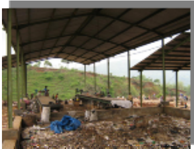
Gambar 7.1 Bangunan untuk komposting yang merupakan bantuan Bank Dunia di TPABabakan
