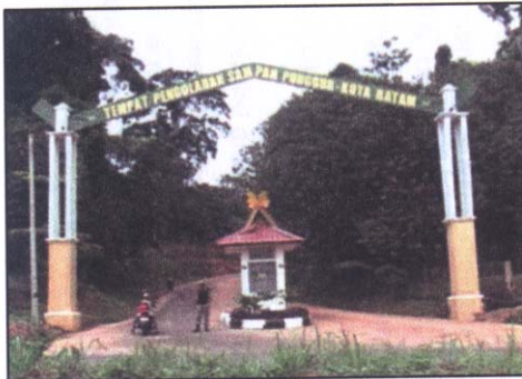
Pintu Gerbang TPA Telaga Punggur, Batam
