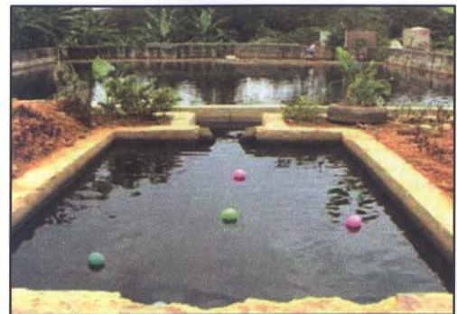
Pengelolaan Air Lindi dengan Teknologi FBBR Dibantu Bakteri Probiotik
