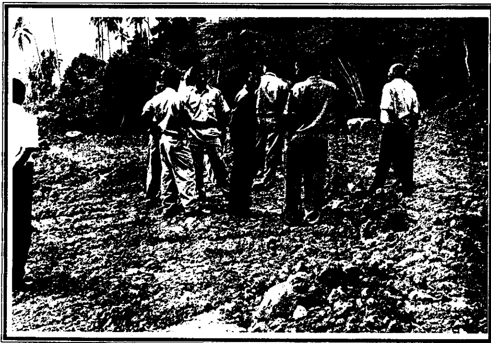
Gambar 1. Kerusakan Tebing tanjakan Balohan mengancam Jalur Jalan Sabang.
