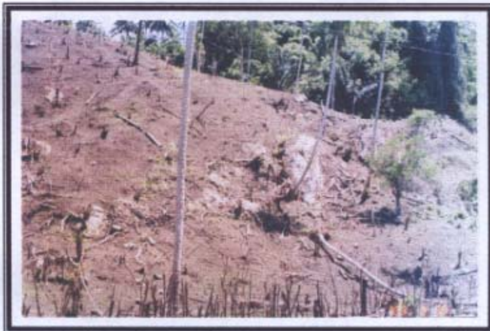
Kerusakan Lingkungan / Degradasi Tebing
