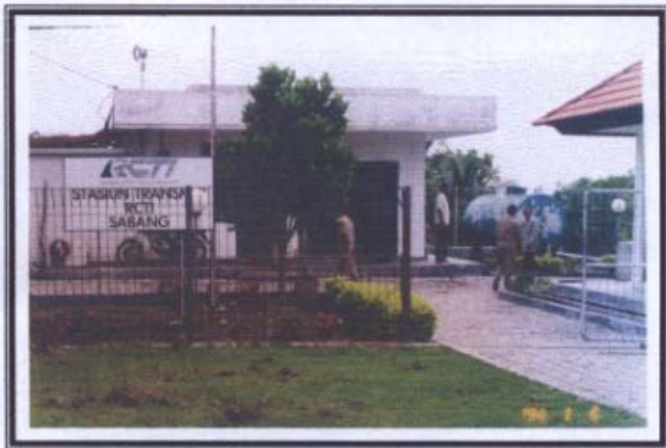
Pengendalian HO dan Limbah B3 Stasiun Transmisi RCTI
