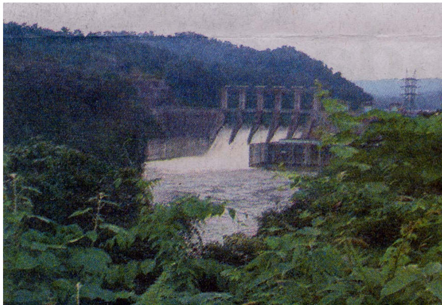
Gambar 3. 21 : Pembukaan Pintu Air Bendungan PLTA Koto Panjang
