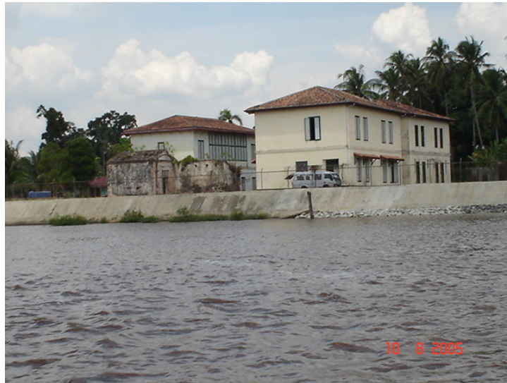
Gambar 3.27 : Pembangunan Turap Untuk Menghalangi Abrasi
