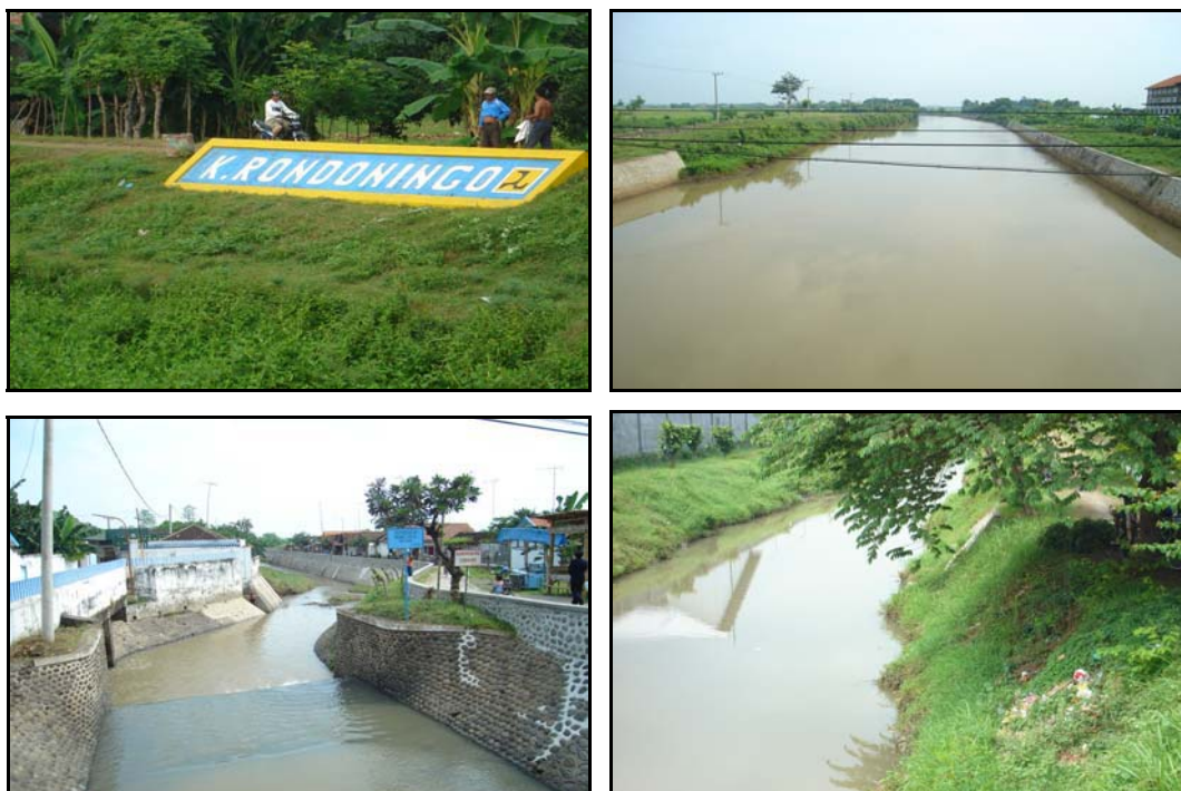
KONDISI SUMBERDAYA AIR
