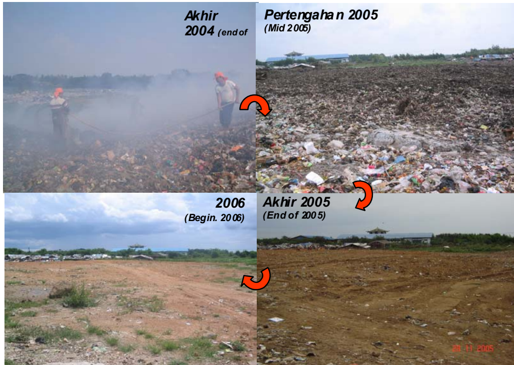
Gambar 7.7. TPA Rawa Kucing : dari Open Dumping menuju Semi-Aerobik Landfill (From Open Dumping to Semi Aerobic landfill)
