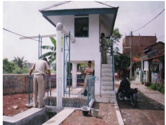
Gambar 3.11. Rumah Pompa di Kota Tangerang
