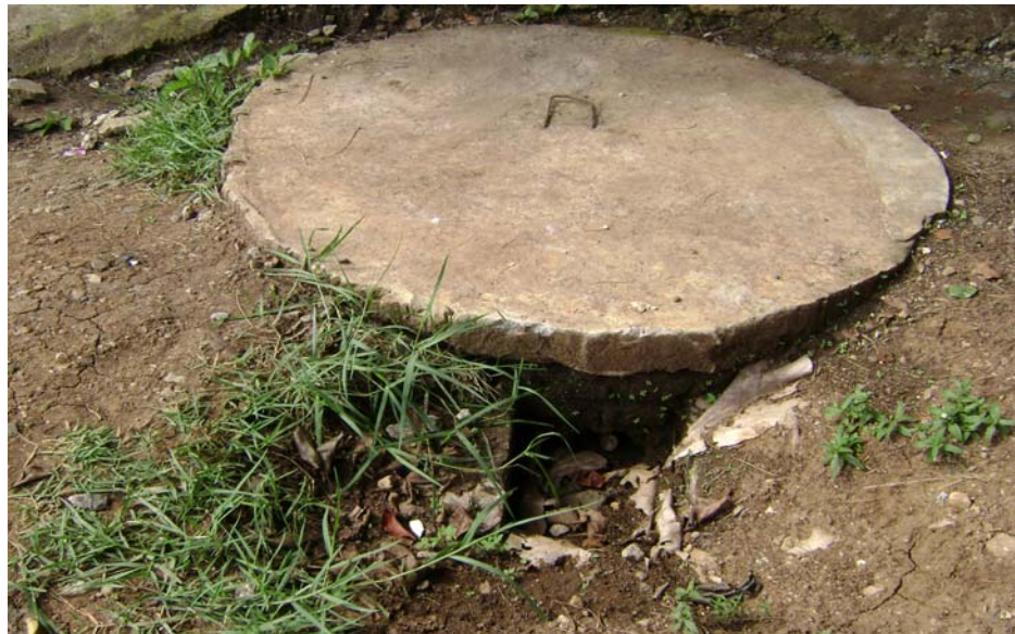
Gambar III.2. Pembuatan Sumur Resapan
