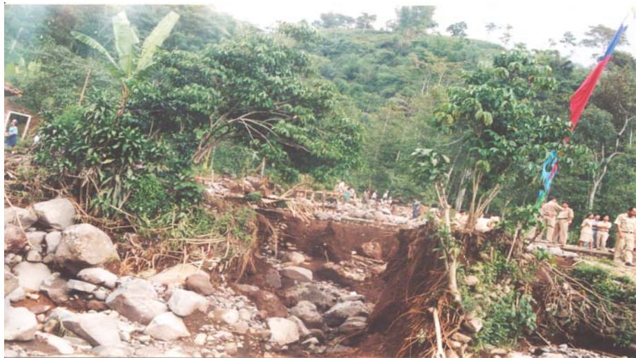
Gambar V.2. Tanah Longsor Yang Terjadi di Kab. Magetan
