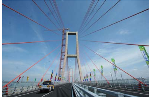
Pembangunan Jembatan Suramadu
