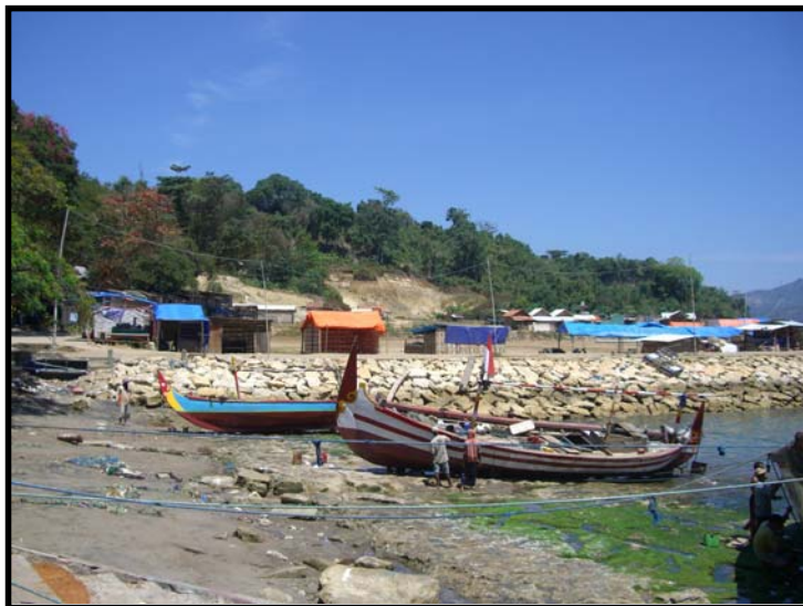
Gambar 7.4. PPI Tulungagung Dalam Proses Pembangunan
