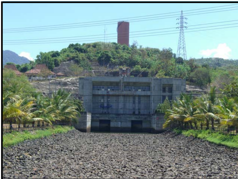
Gambar 7.2. Gambar PLTA Tulungagung
