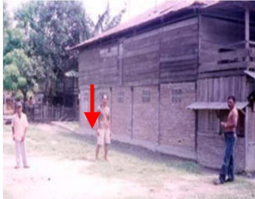
**Gambar 3.23** Bagian belakang rumah mengalami penurunan pada saat Gempa Bora, 24 Januari 2005
