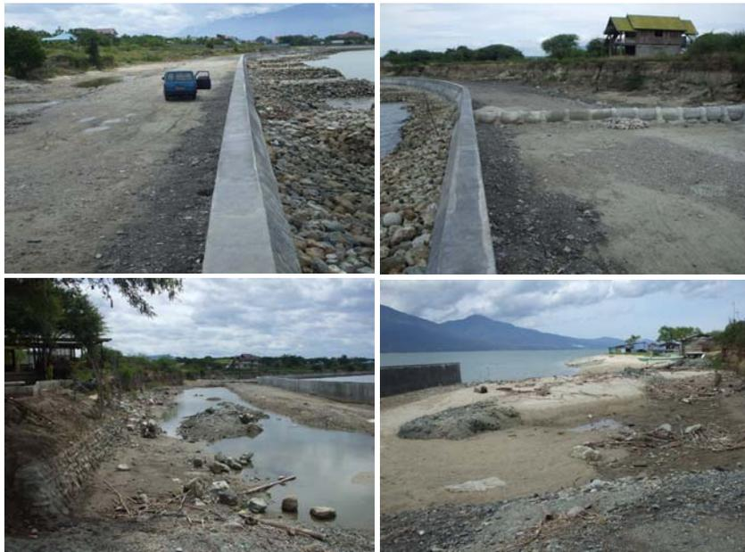
**Gambar 4.1** Pembangunan Jalan Lingkar Teluk Palu pada segmen Talise – Tondo membutuhkan banyak material timbunan
