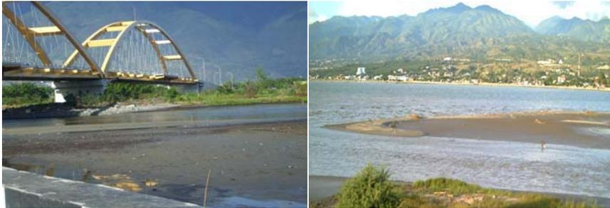
**Gambar 3.12 Muara Sungai Palu yang mengalami pendangkalan intensif karena banyaknya aliran sedimen dari hulu**
