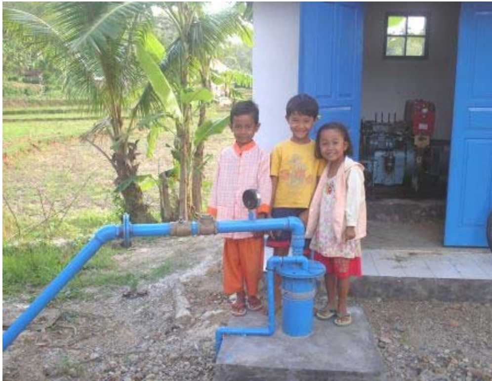
Gambar :4.8. Sumur bor bantuan Badan Geologi Nasional dengan kedalaman bor tanah 150m di daerah Sambong, tujuannya untuk mendapatkan air bagi daerah yang kecukupan airnya kurang.
