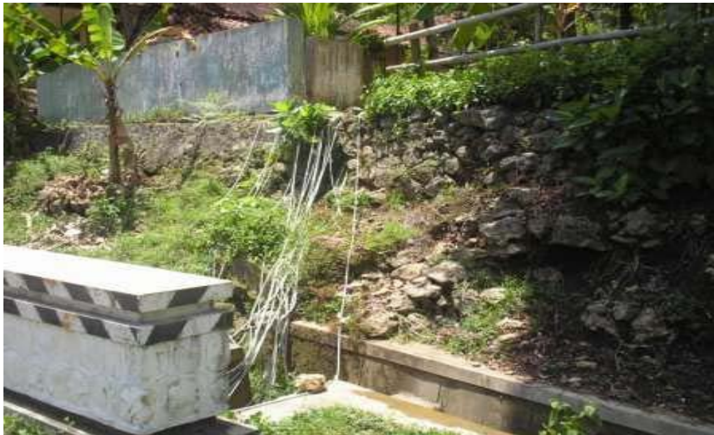
Gambar 4.11. Pipa/Slang-slang plastik, berfungsi untuk menyalurkan air ketempat penampungan air di rumah-rumah masyarakat dilakukan secara swadaya.
