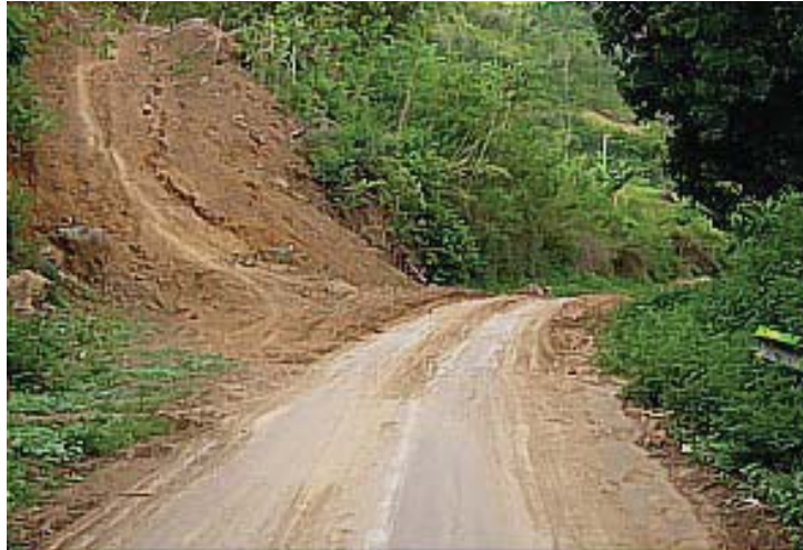
Gambar 5.8. Longsor Tanah di Jalan Raya Sekotong
