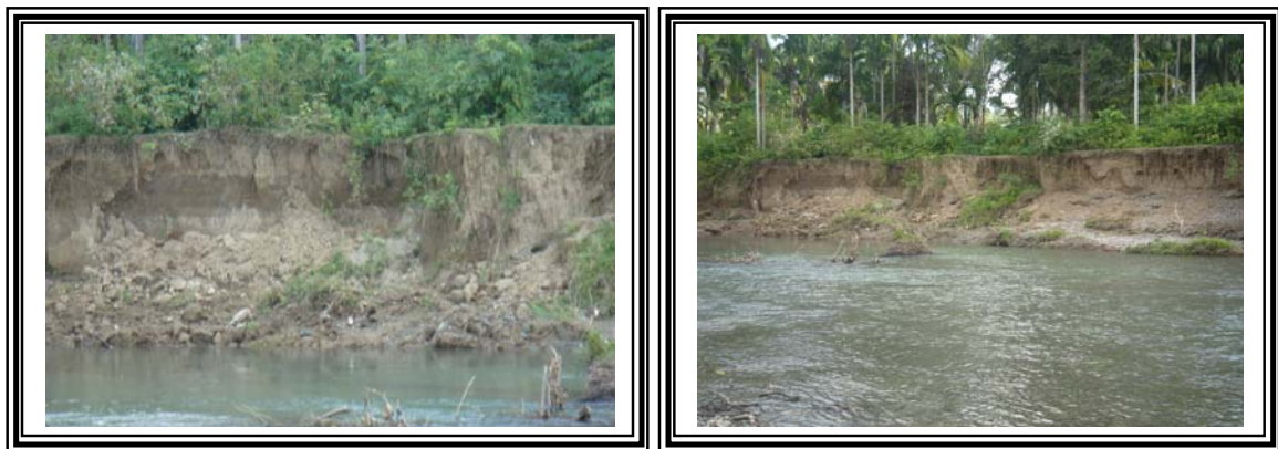
Kondisi tanggul di sepanjang DAS yang banyak mengalami kikisan dan longsor
