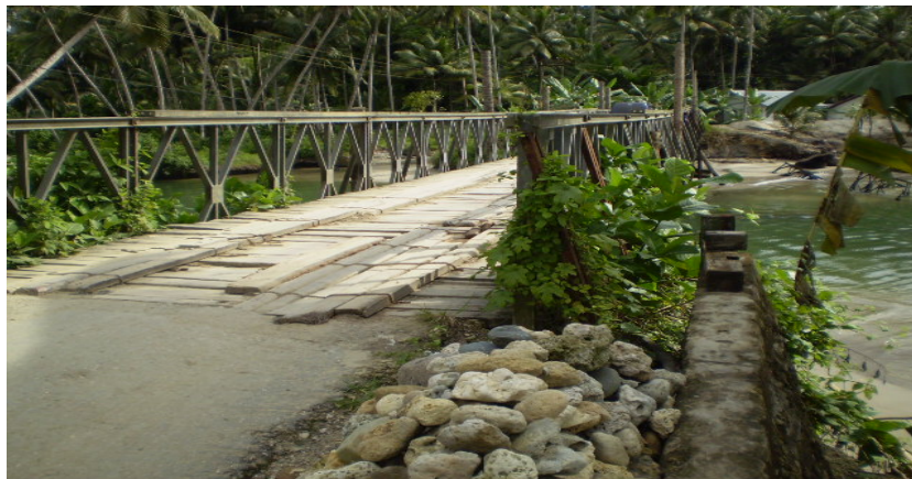
Gambar. 2.8. Jembatanyang terancam ambruk
