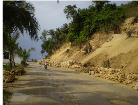
Gambar. 2.5. Badan jalan yang terkena longsor
