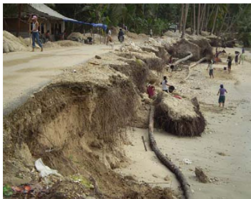
Gambar. 2.5. Badan jalan yang terkena longsor
