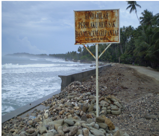
Gambar 2.6. Tembok Penahan Ombak dan Gelombang Laut yang Terancam Hancur
