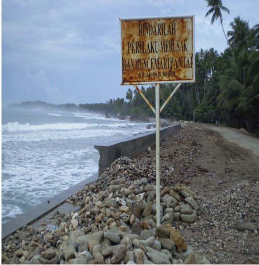
Gambar 2.6. Tembok Penahan Ombak dan Gelombang Laut yang Terancam Hancur Photo : Oktober 2007, Kecamatan Telukdalam-Nias Selatan
