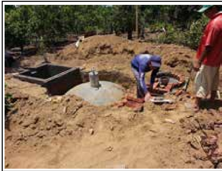
Gambar 3.6 Pembangunan Instalasi Biogas
