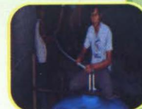
d. Pasang kran gas kontrol pada salah satu pipa paralon yang ada di bagian atas kubah reaktor, sedangkan satu pipa lainnya di sambungkan ke dapur.
