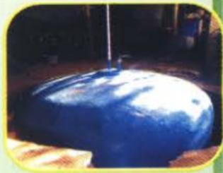
e. Penimbunan tanah sekeliling reaktor dilakukan apabila reaktor telah terisi kotoran ternak.
