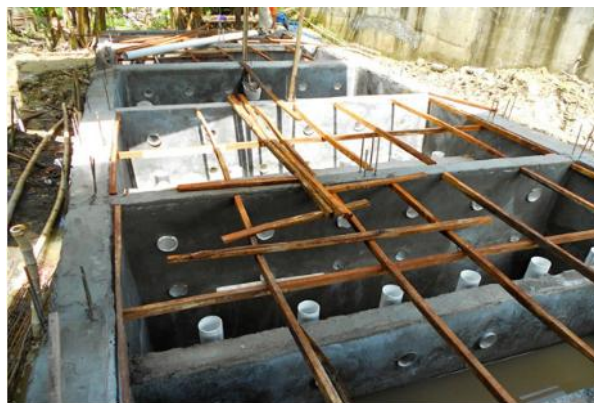
Gambar 19 Pembangunan Tempat Pembuangan Limbah Cair
