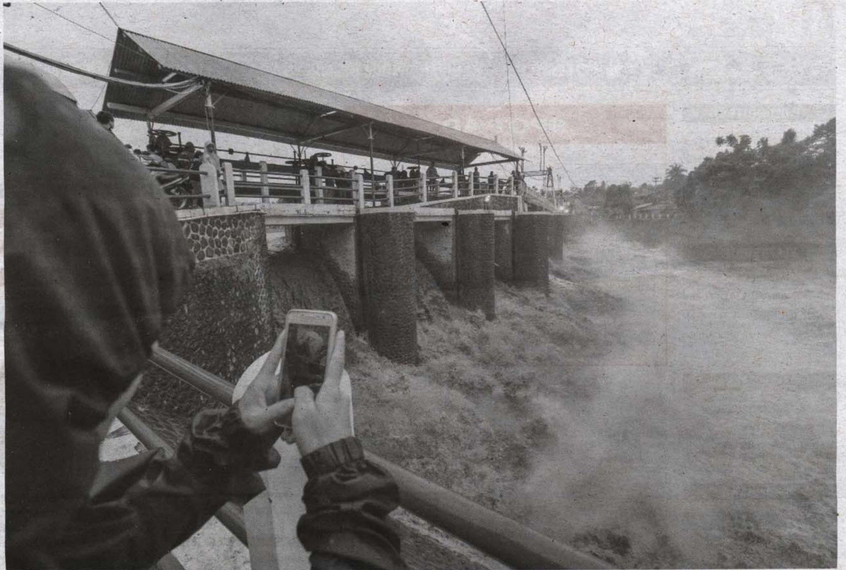
Bendung Katulampa, Bogor, Jawa Barat, 5 Februari 2018.
