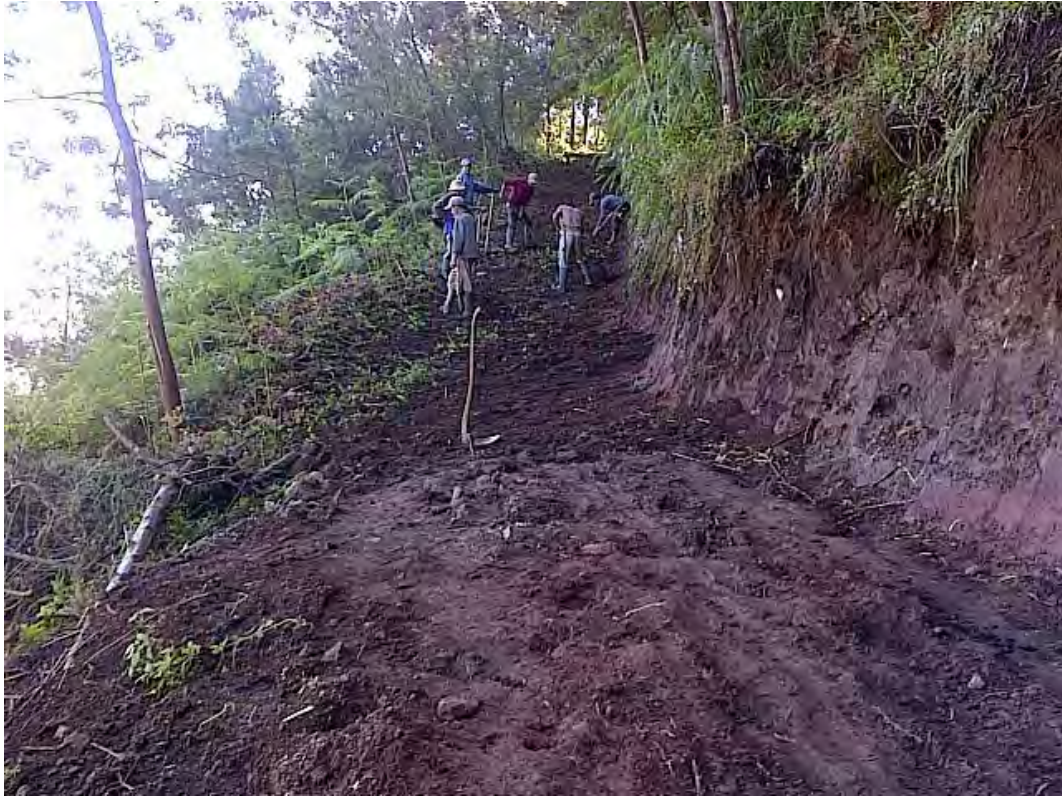
Pembuatan Jalur Larang Api untuk memutus penyebaran kebakaran hutan
