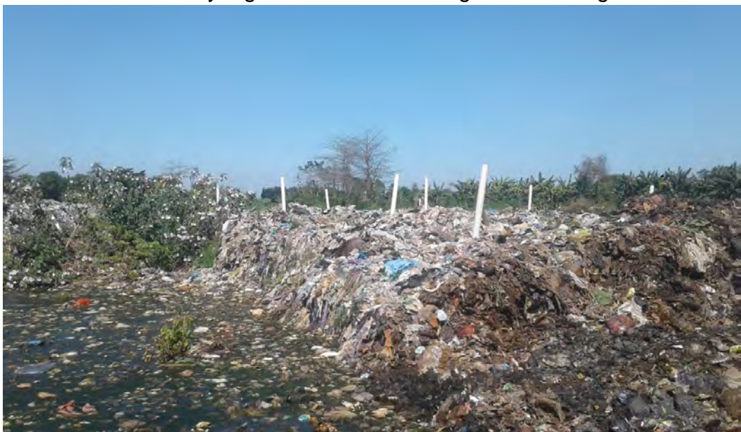
Pipa penangkap Gas
