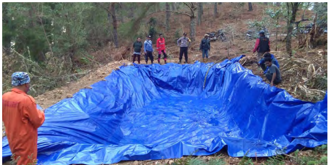
Pembuatan embung di Gunung Lompobattang untuk menangani kebakaran hutan
