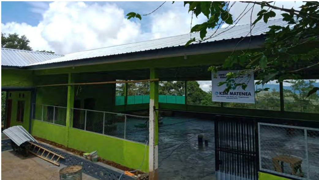
TPS 3R di Kecamatan Tinggimoncong
