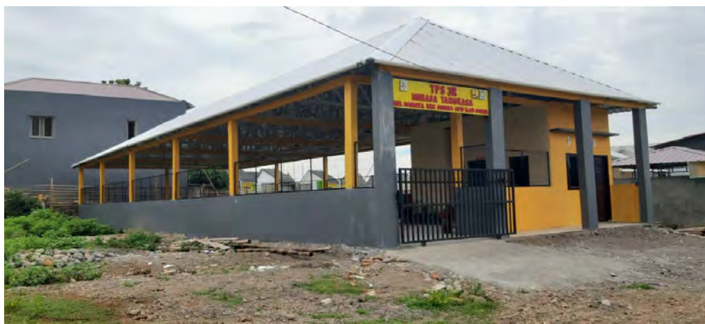
TPS 3R Kecamatan Somba Opu
