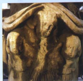
Gambar 4. Bangunan Bersejarah Yang Terkena Dampak Deposisi Asam
