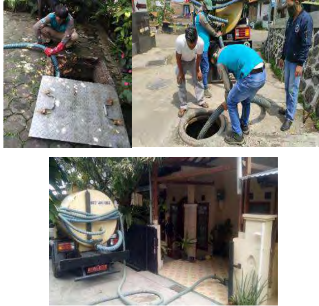
Gambar 4.33 Proses Penyedotan Lumpur Tinja
