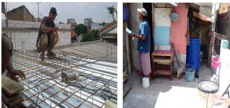
Gambar 4.22 Proses Rehabilitasi Rumah Tidak Layak Huni
