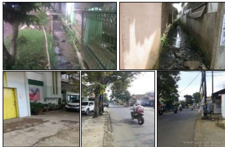
Gambar 2.67 Kondisi Saluran Drainase di Kelurahan Citeureup
