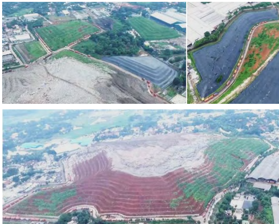
Gambar IV-11 Tampak Atas Zona Landfill mining Bantargerbang Tahap 1
