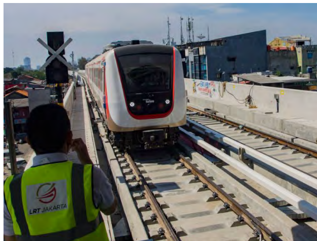
Gambar IV.9 Progres Pembangunan LRT Jakarta
