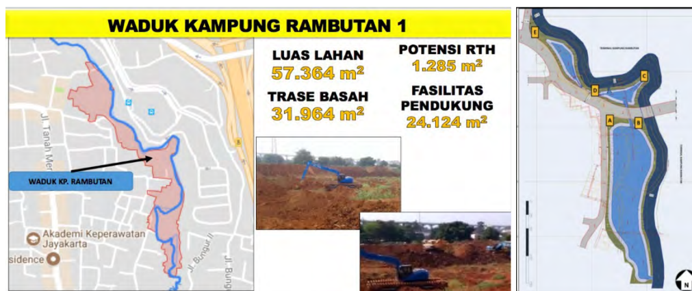
Gambar III.4 Gambaran Umum, Desain dan Kondisi Pembangunan Waduk Kampung Rambutan 1
