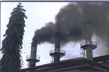
Sumber Pencemaran Udara dari Instalasi Boiler
